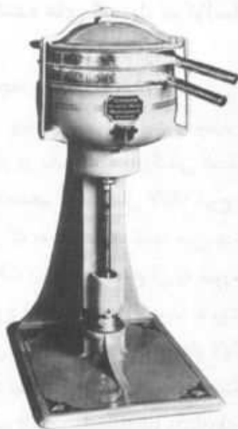
شکل ۲-۲-۶ یکی از اولین سپراتورهای مدل Alfa ساخته شده در سال ۱۸۸۲
